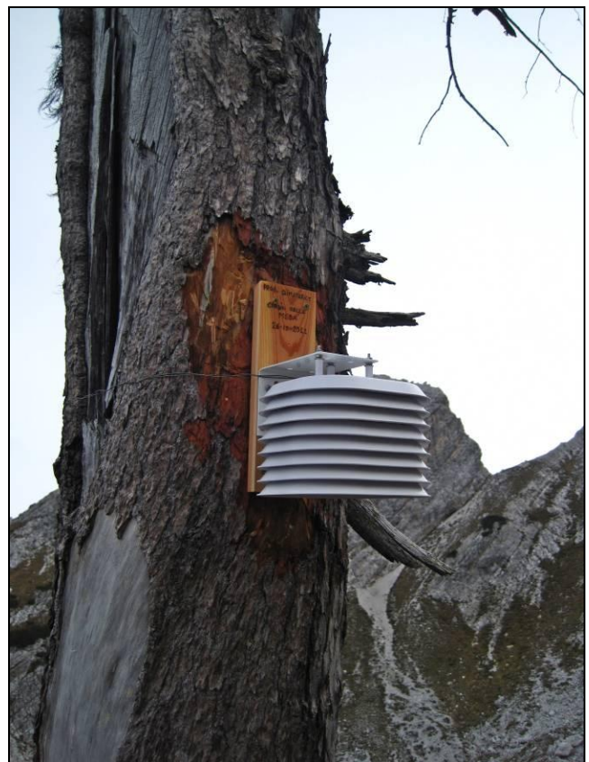
Figura 24 - Un'immagine del rilevatore di temperatura con schermo solare installato al Ciadin della Meda.
