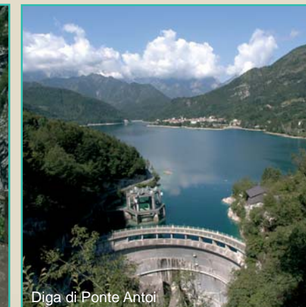
Diga di Ponte Antoi
